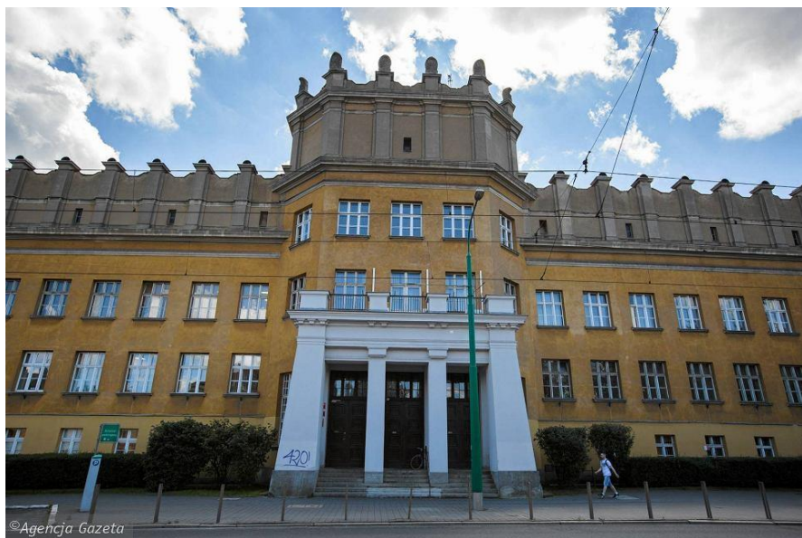
Coll. Chemicum od strony ul. Grunwaldzkiej – główne wejście.
